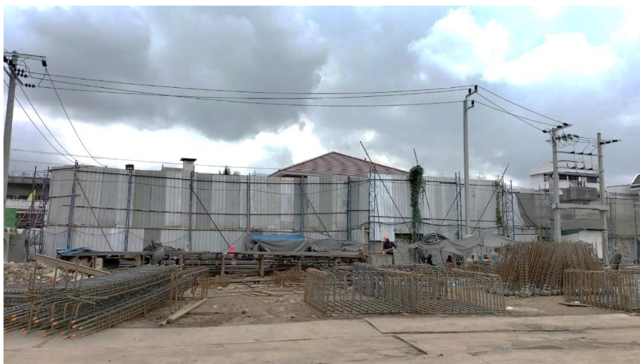
รูปที่ 38 จัดพื้นที่สำหรับตัด / เชื่อมโลหะ ห่างจากจุดเก็บวัสดุไวไฟ
