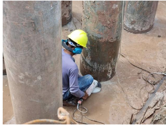
รูปที่ 19 ใช้สายยางสเปรย์น้ำในการตัดเสาคีม
